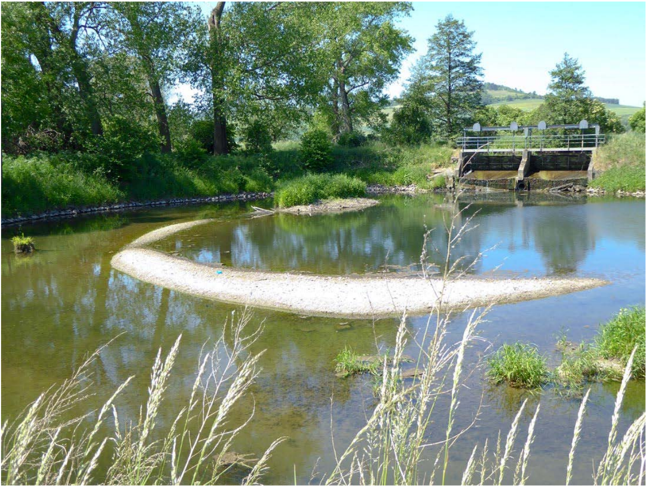
Vertiefter Leinebereich vor der Stauvorrichtung
