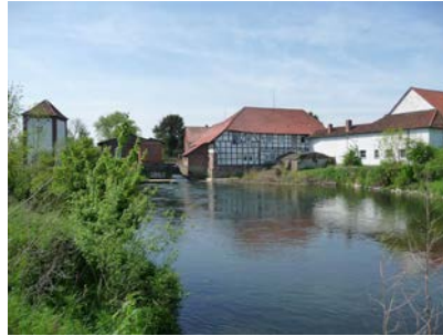
Großer Kolk unterhalb der Mühle
