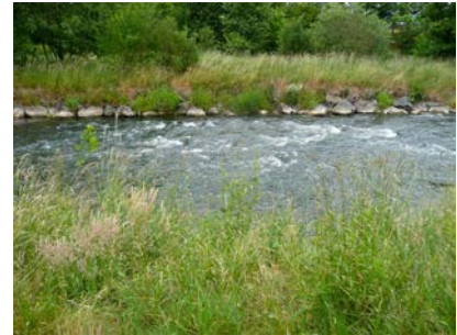
Starke Wasserverwirbelungen an der Sohlschwelle
