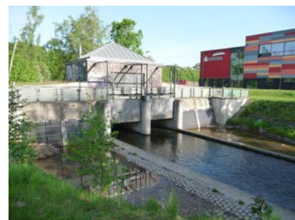
Absperrbauwerk und Schöpfwerk
