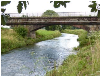
Eisenbahnbrücke über die Leine
