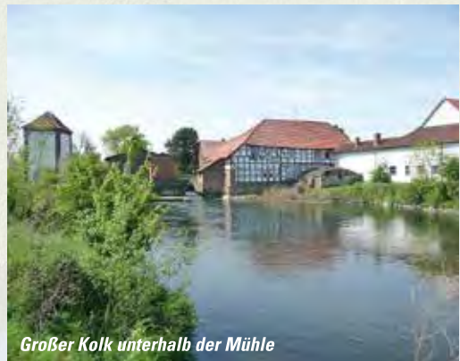
Stauwehr an der Leinemühle
